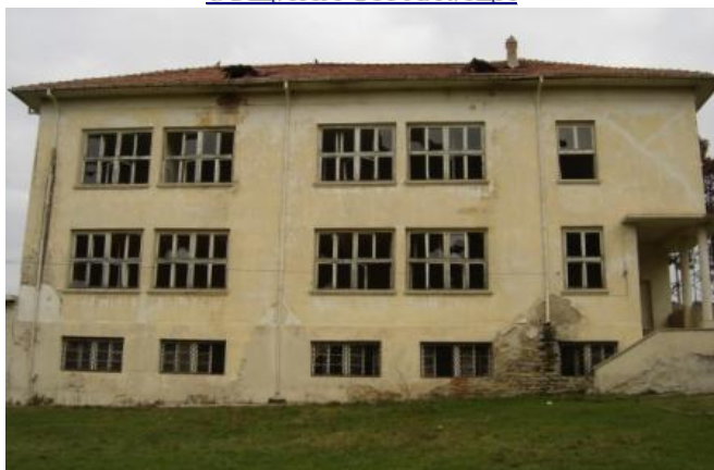
ОБЕКТ „ СГРАДА № 4“ С. БАЛКАНЦИ, ОБЩИНА СТРАЖИЦА
