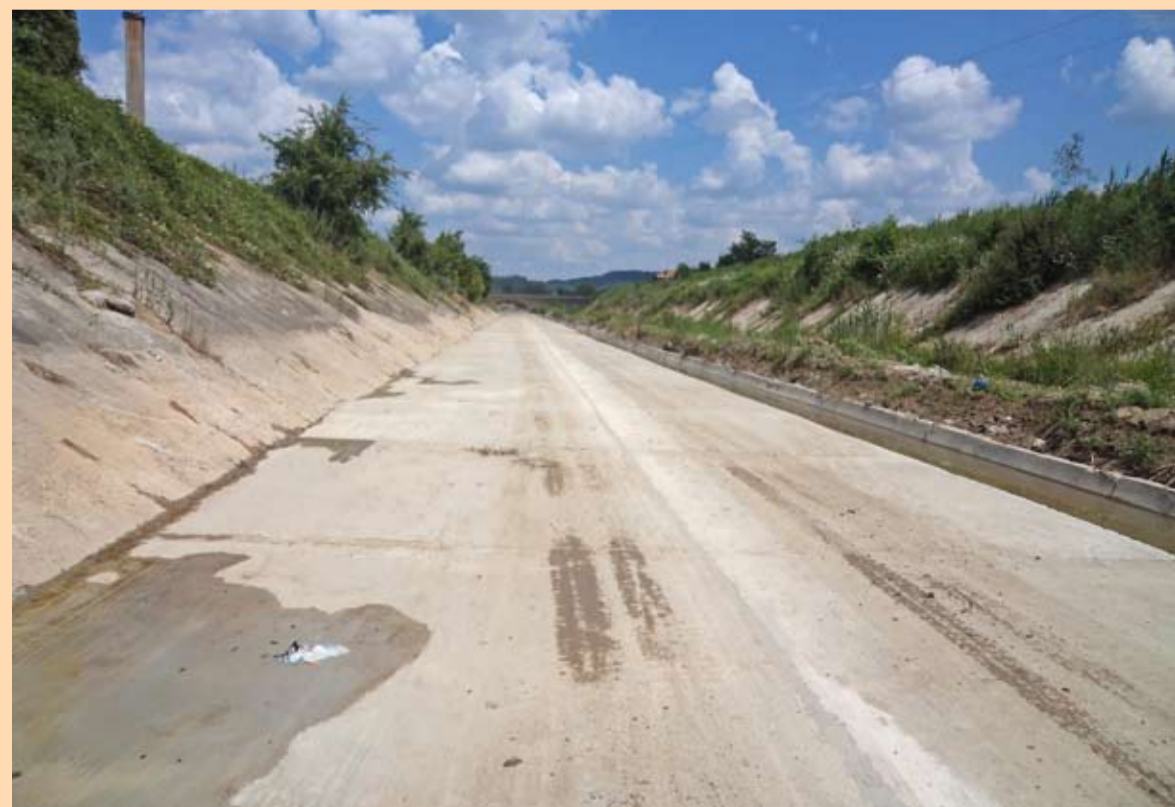
Беше ремонтирано коритото на Голяма река, град Стражица.
